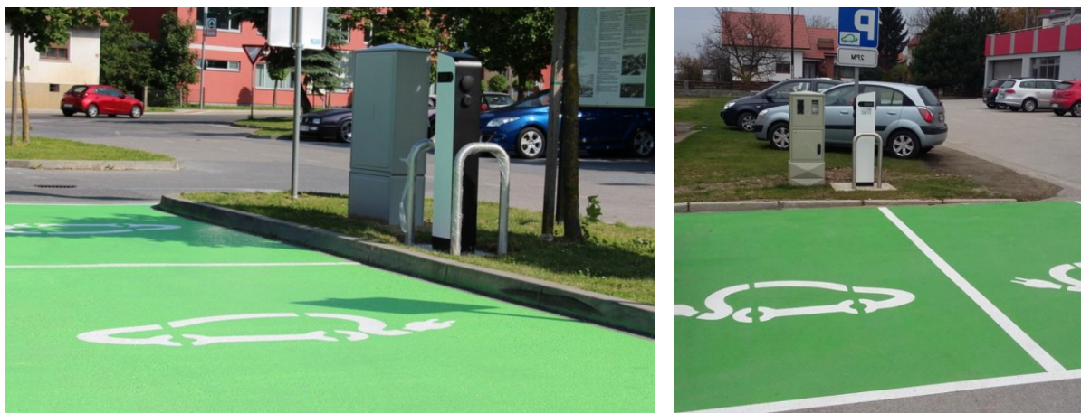
Slika 10: Prikaz parkirnega stebrička na polnilnih mestih za zaščito polnilnic
